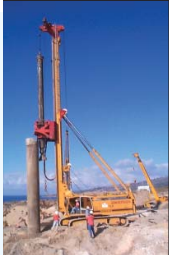
Wirth ECO 35 installs shear pin.
